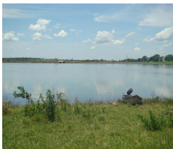
Foto - 36. Vista geral da margem direita bem estabilizada, próxima ao barramento da usina.
