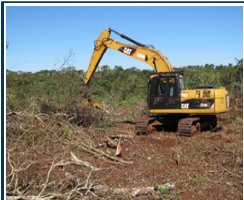
Máquinas concluindo a limpeza do futuro reservatório da PCH Verde 4.
