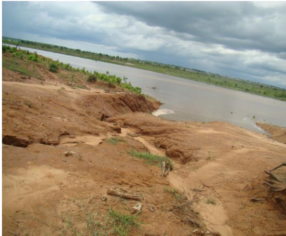
Foto - 13. Área na margem direita, onde está o PE2 a ser alagado completamente com o enchimento do reservatório.
