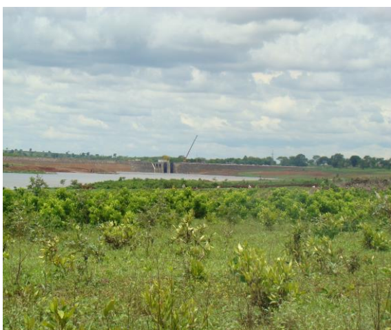
Foto - 15. Vista geral da área nas proximidades do barramento da PCH Verde 4.
