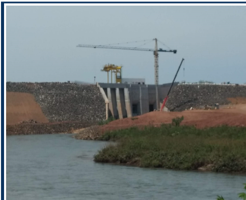
Vista parcial da construção do barramento da PCH Verde 4.
