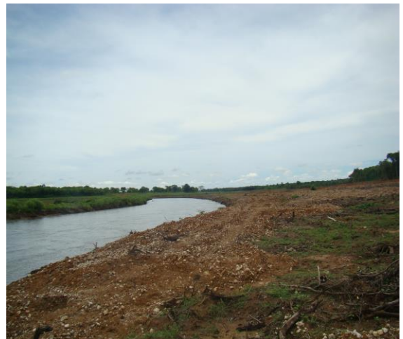
Foto - 24. Vista geral da área AM4 com margens estabilizadas.
