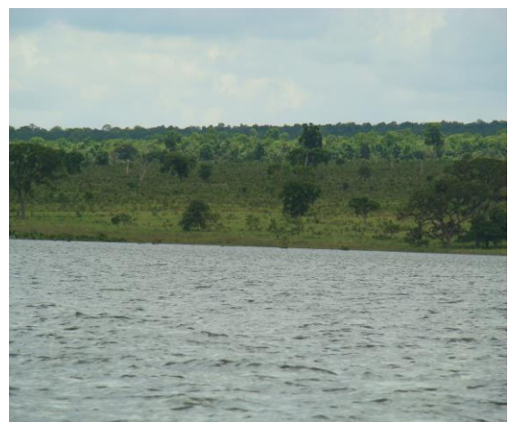
Foto - 25. Vista da margem esquerda estabilizada próximo da AM1.
