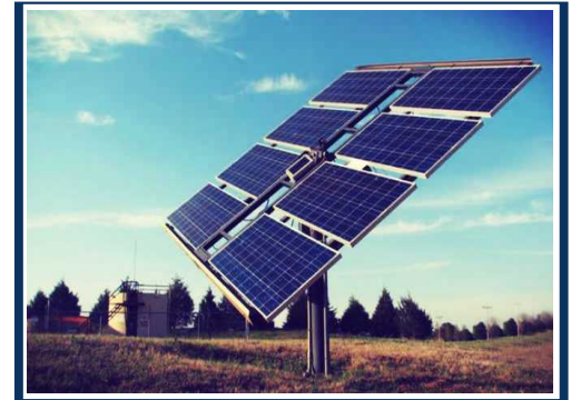
Geração de energia fotovoltaica.
